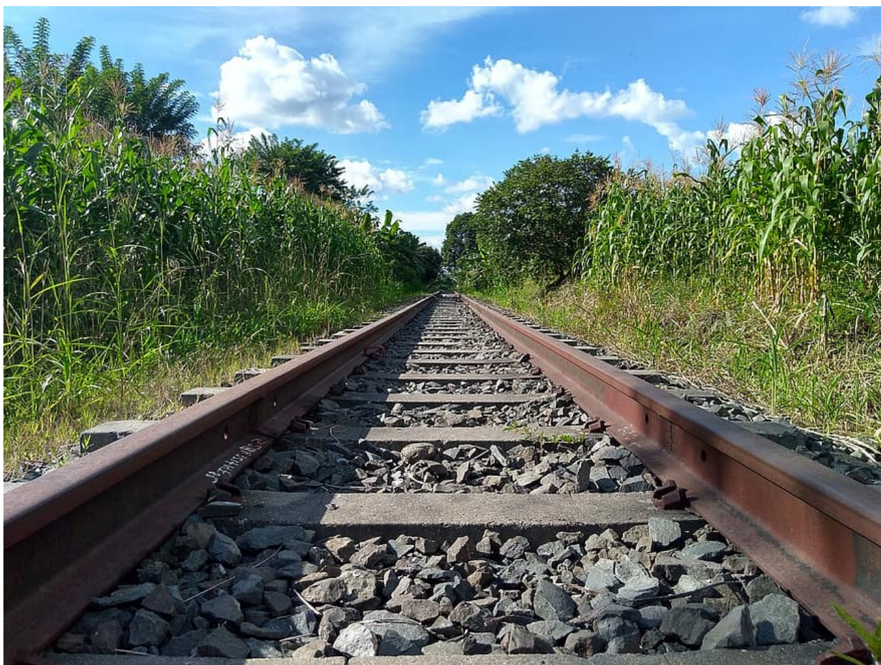
Vía de ferrocarril
