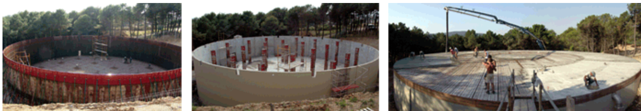
Fases de una obra civil
